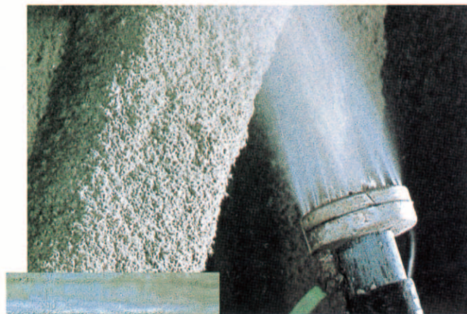
吹付けロックウール (NM-8061)
