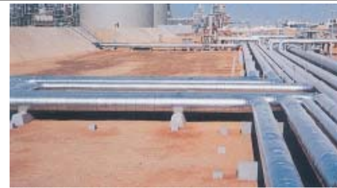
●パイプラインの断熱
