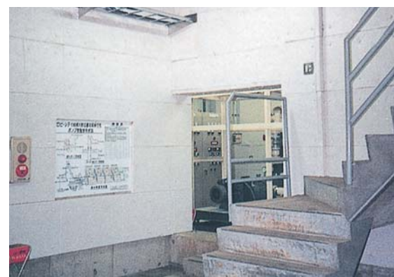
機械室・壁の断熱吸音
