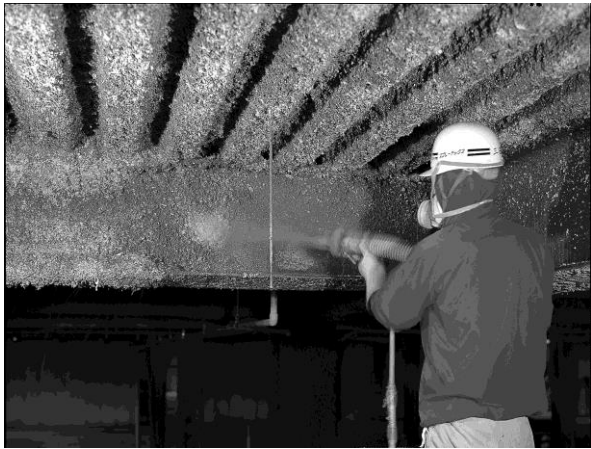
吹付けロックウール (NM-8601)
