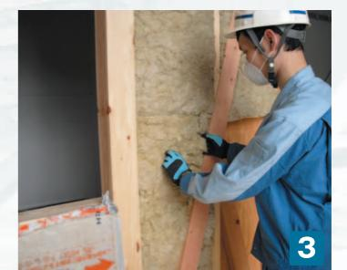
筋交いの両側に沿って、マットに厚み半分ほど切り込みを入れ、マットを筋交い見付面に同面となるよう引き出します。
