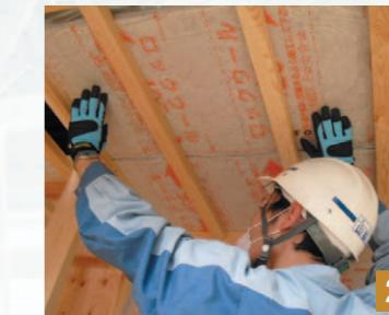
野縁の上にマットを隙間が生じないように敷き込んでいきます。
