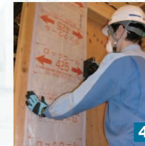
剥がした付属防湿フィルムを戻し、フィルム耳を柱見付面にタッカーで留付けます。
