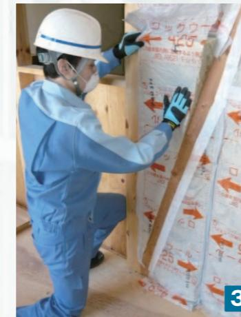
分割したマットを筋交い裏部→三角部の順に入れ、柱・間柱はタッカーで留付けます。
