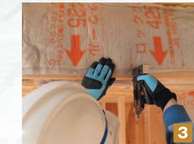
下がり壁部分に、寸法に合わせてカットしたマットを充填していきます。
