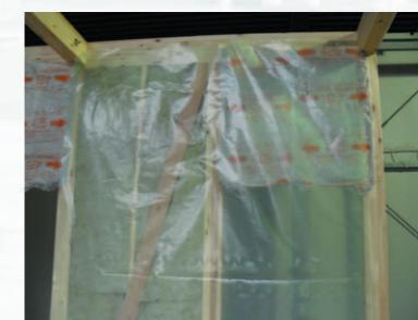
別張り防湿フィルムの継目部分をタッカーで留付けます。
