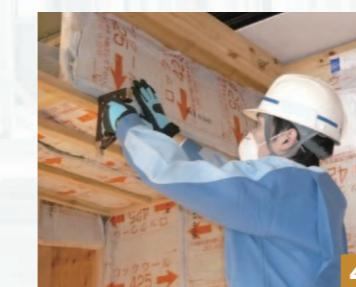
フィルム耳は下がり壁のはり・柱の見付面にタッカーで留付けます。
