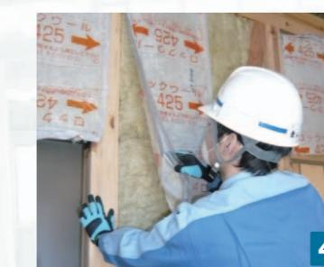
剥がした付属防湿フィルムをかぶせ、柱・間柱と筋交いにタッカーで留付けます。
