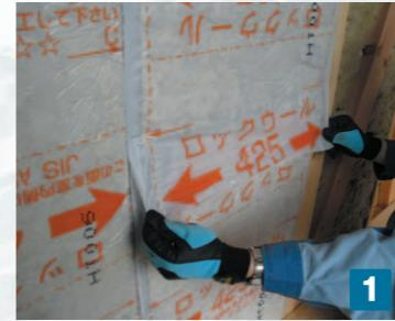
上のマットに下のマットを密着させて、フィルム耳を柱・間柱の見付面にタッカーで留付けます。
