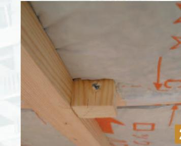
吊木周りに隙間を生じさせないようにマットを突き付けます。
