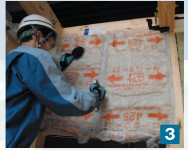
柱見付面にフィルム耳をタッカーで留付けます。
