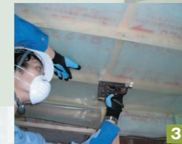
野縁の室内側に別張り防湿フィルムを施工します。
