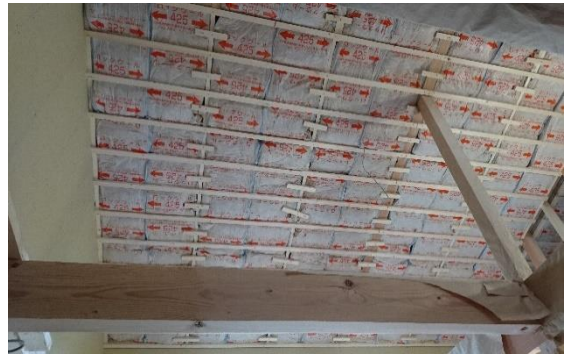
【天井施工 ※防湿シート施工前】
