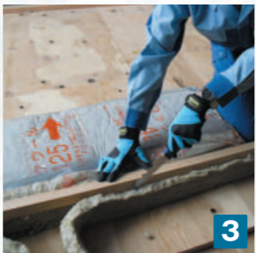
3 壁幅の寸法を測定し、約20mm余裕を見た寸法で、添板を押し当ててカットします。
