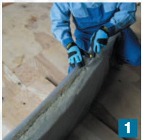
1 側面の透湿フィルムをカットします。
