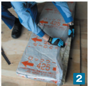
2 付属防湿フィルムをカットする位置まで切がしておきます。
