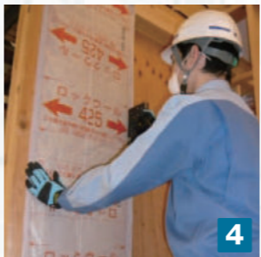
4 剥がした付属防湿フィルムを戻し、フィルム耳を柱見付面にタッカーで留付けます。
