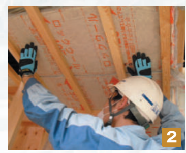
2 野縁の上にマットを隙間が生じないように敷き込んでいきます。
