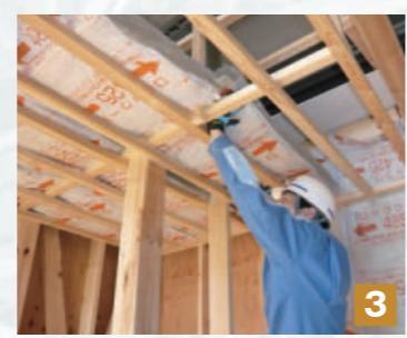
3 隙間が生じないようにマットを奥に敷き詰めます。
