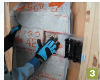
3 マツをCBの裏に入れ込み、フィルム耳をタツカーで固定します。
