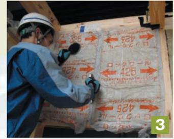
3 柱見付面にフィルム耳をタツカーで留付けます。(約200mmピツチ)
