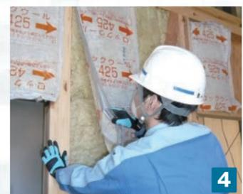
剥がした付属防湿フィルムをかぶせ、柱・間柱と筋交いにタッカーで留付けます。別張り防湿フィルムを施工する場合は、剥がした付属防湿フィルムは使いません。
