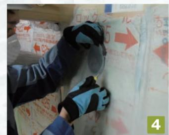
4 別張り防湿フィルム施工後、配管部のフィルムをカットします。
