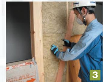
3 筋交いの両側に沿って、マツに厚み半分ほど切り込みを入れ、マツを筋交い見付面に同面となるよう引き出します。
