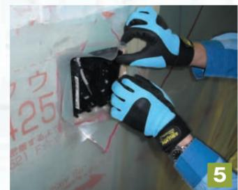
5 カットしたフィルムをマツと別張り防湿フィルムの間折り込みます。その後CBカバーのつばを引き出します。
