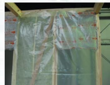
別張り防湿フィルムの継目部分をタッカーで留付けます。(約200mmピッチ)
