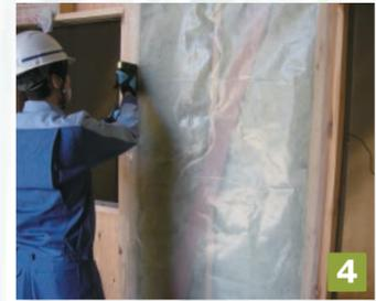
4 別張り防湿フィルムを柱・間柱と筋交いにタツカーで留付けます。
