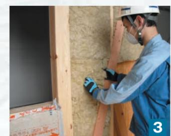
筋交いの両側に沿って、マットに厚み半分ほど切り込みを入れ、マットを筋交い見付面に同面となるよう引き出します。
