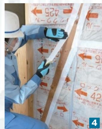
筋交いとマットの継ぎ目は、気密テープで処理します。
