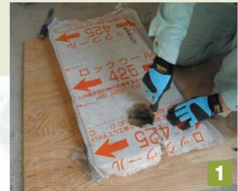
1 貫通する配管の径より10mm程度小さめにマツを開口します。
