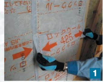
1 上のマットに下のマットを密着させて、フィルム耳を柱・間柱の見付面にタッカーで留付けます。
