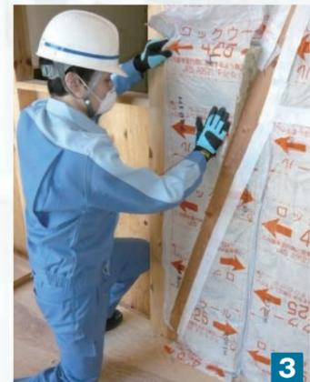
分割したマットを筋交い裏部→三角部の順に入れ、柱・間柱はタッカーで留付けます。
