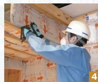
4 フィルム耳は下がり壁のはり・柱の見付面にタッカーで留付けます。
