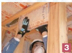
3 天井のマットと隙間が生じないように、気流止めを差し込みます。
