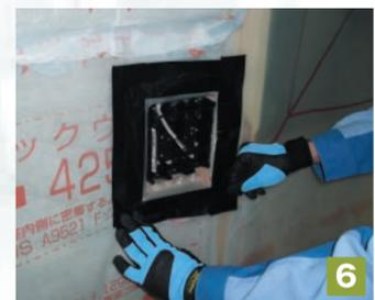
6 引き出したCBカバーのつば部分を気密テープで処理します。
